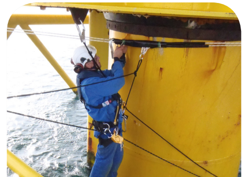
Prüfer beim Offshore Einsatz
